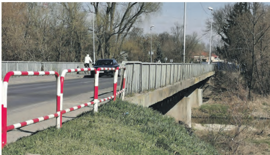
Most na ul. Mostowej zostanie rozebrany niemal całkowicie, pozostaną tylko filary, na których wzniesiona zostanie nowa konstrukcja.
