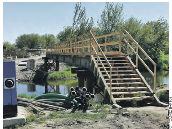
Tak wygląda kładka techniczna wybudowana przez spółkę z Będzina w Kominie, gdzie na zlecenie łowickiego starostwa buduje ona nowy most. Podobnej, tylko z pochylnią, można się prawdopodobnie spodziewać w Łowiczu.
