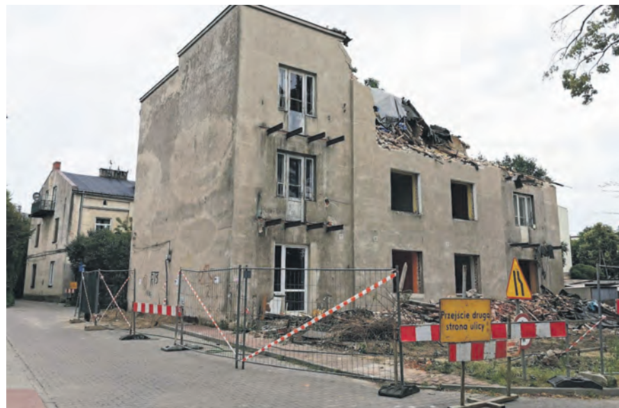
Na miejscu rozbieranej kamienicy stanie nowy budynek mieszkalny.
