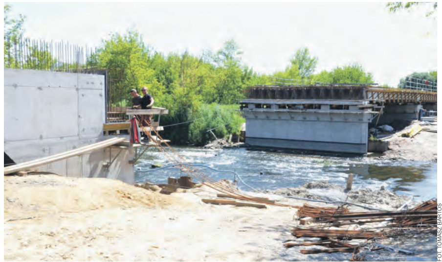
Na zdjęciu widać przyczółek mostu od strony Kompiny oraz już wykonaną konstrukcję mostu od strony Bednar.
