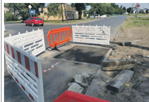
Miejsce po dziurze w jezdni na ul. Katarzynów już zakryte i zaasfaltowane.
