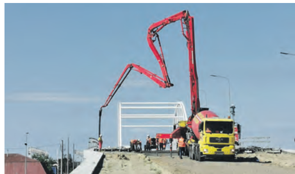
27 lipca na wiadukcie zalano ostatnie betonowe elementy na jego przyczółkach. Po raz pierwszy od dłuższego czasu można było na nim zobaczyć kilkunastu robotników Trakcji.
