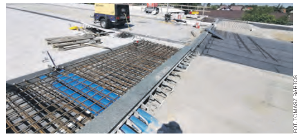
Ostatnie nie zalane elementy zbrojenia na przyczółkach wiaduktu – zdjęcie z ubiegłego tygodnia.
