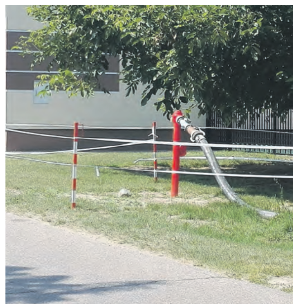
Wykonawcy inwestycji korzystają również z wody z sieci wodociągowej.
