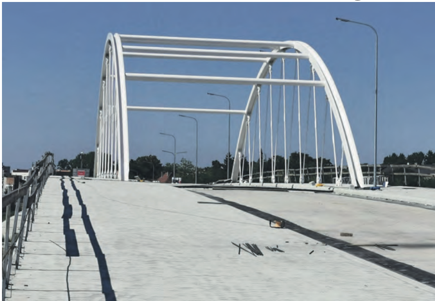
Konstrukcja wiaduktu jest ukończona, brakuje jeszcze asfaltu, poliuretanu na chodnikach oraz barier, aby można było mówić o finiszu prac.
