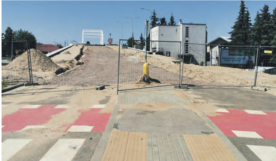
Widok na nasyp i wiadukt od strony ul. Warszawskiej, widać nawieszony już kilka tygodni temu tłuczeń pod asfalt i piach w miejscu gdzie powstaną chodniki.
