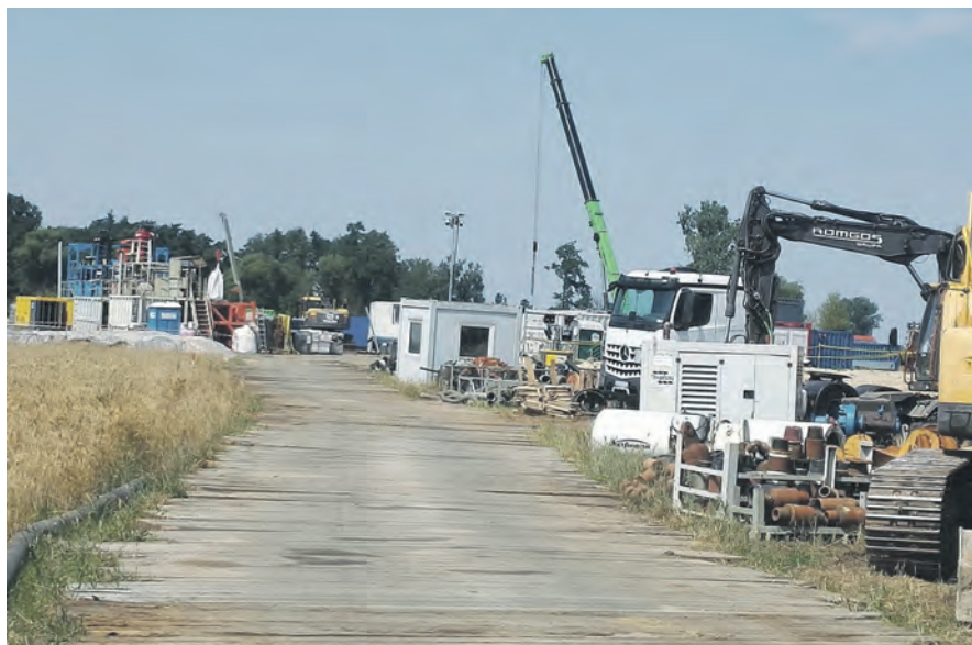
Prace na terenie gminy Łowicz trwają już od miesiąca.
