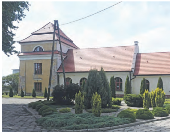
Prace nad elewacją i wnętrzem spichlerza ruszą już w przyszłym roku.
