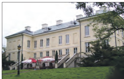
Pałac w Walewicach, widok od strony parku, archiwum autorów tekstu
