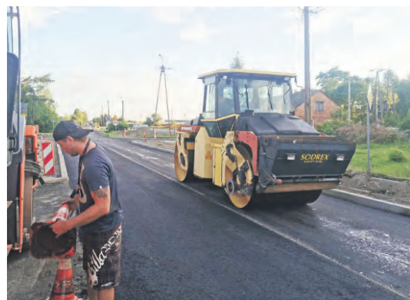
Prace przy naprawie nawierzchni DW 584 w Sannikach.
