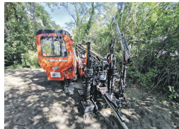
Specjalistyczne urządzenie do wykonywania przecisków sterowanych zostało zainstalowane na skwerze przy ul. Kaliskiej.
