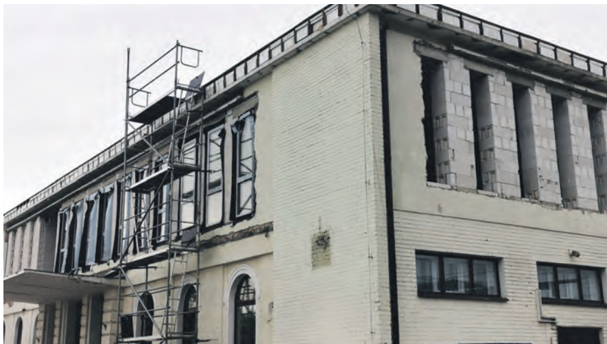
Zabytkowy budynek dworca PKP Łowicz Główny zmienia swoje oblicze za sprawą kompleksowego remontu.
