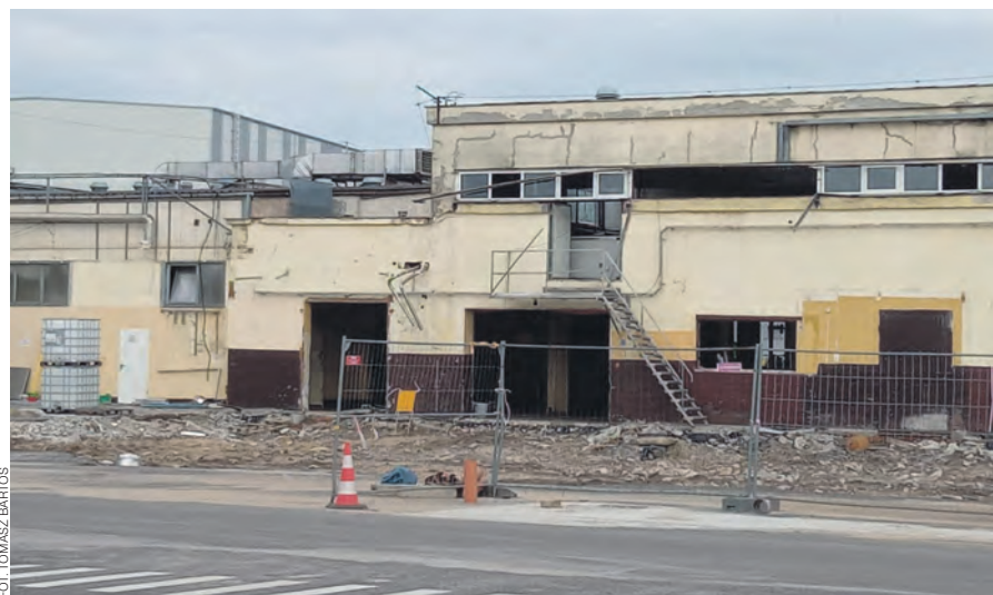
Prace rozbiórkowe starej części zakładu Agros Nova od strony ul. Sikorskiego.
