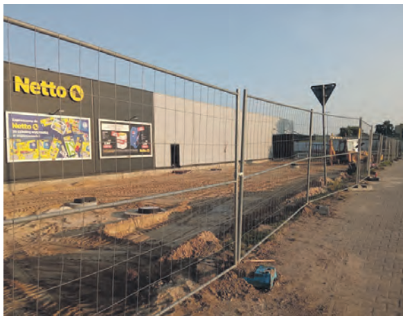
Market budowlany Bricomarché będzie się mieścić w tym samym budynku, w którym jest Netto.
