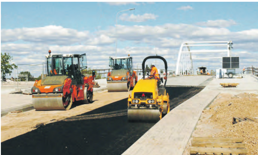
Konstrukcja wiaduktu jest gotowa, czeka on teraz na bariery i asfalt, ten jest obecnie układany na drogach dojazdowych znajdujących się na nasypach.
