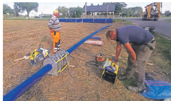
Prace przy zgrzewaniu plastikowych rur.
