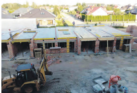
Nowe budynki szeregowców w miniony poniedziałek były przygotowywane do zalania stropów.
