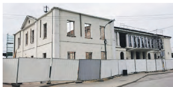
Za jakiś czas prace związane z wykonaniem poszycia dachowego przeniosą się nad historyczną część dworca.
