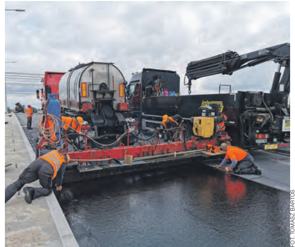
Układanie bitumicznej masy twardo lanej na wiadukcie.
