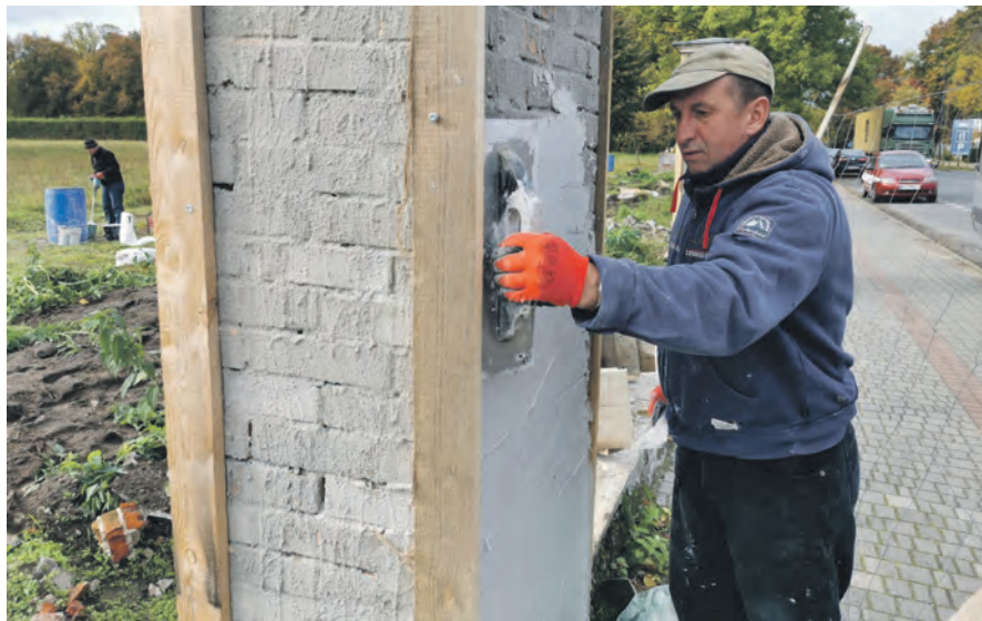
Trwają prace remontowe ogrodzenia wokół zespołu pałacowo-parkowego w Nieborowie.
