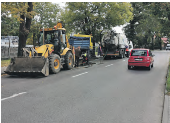
Prace przy usuwaniu ostatniej z czterech awarii wodociągowych na ul. Powstańców.
