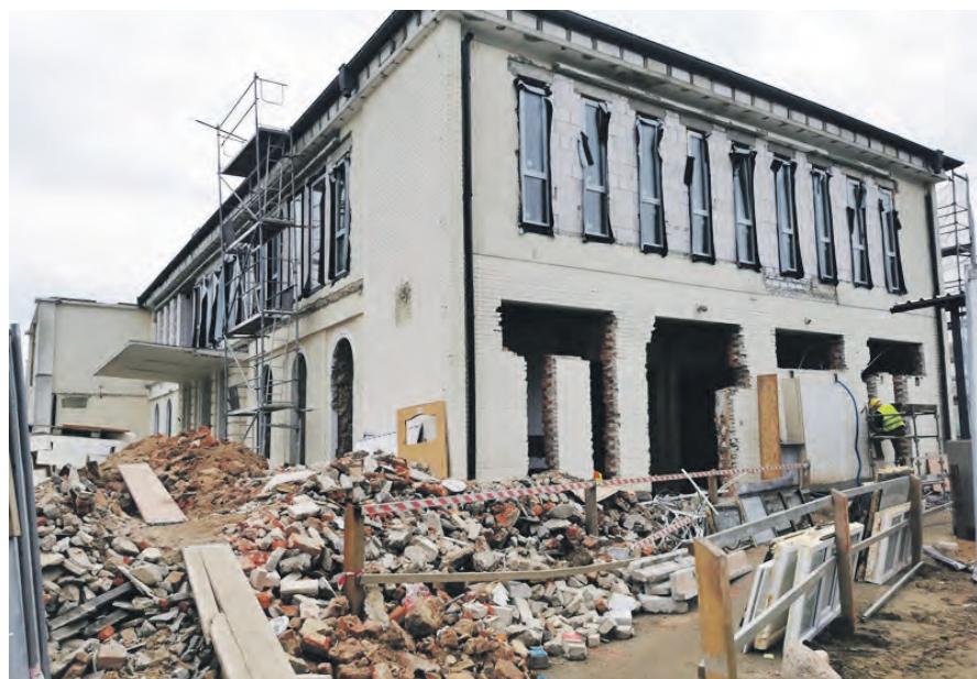
Zakończono między innymi prace rozbiórkowe, izolacje fundamentów, a także niektóre prace konstrukcyjne.
