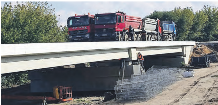
Sześć ciężarówek wypełnionych piachem wjechało na jedno z przęseł, aby je maksymalnie obciążyć do pomiarów.
