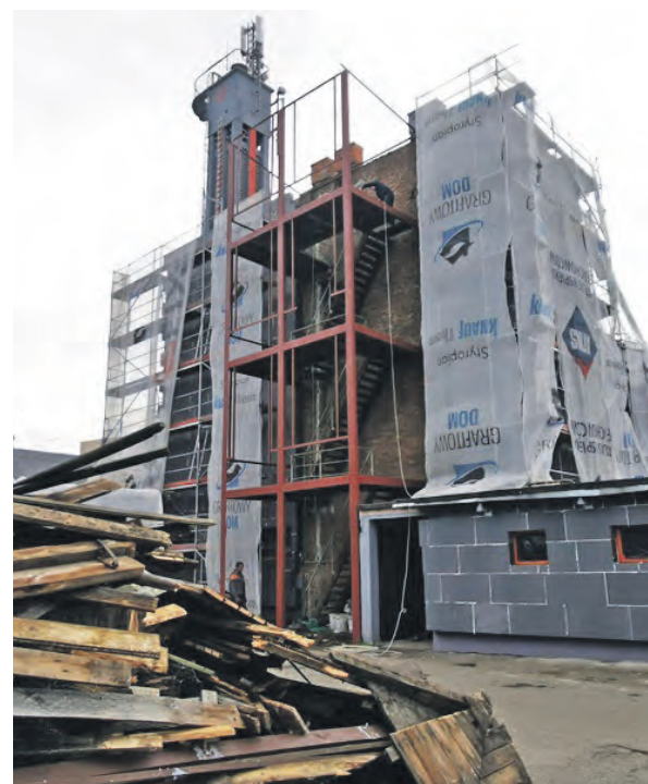
Drewniana wieża ćwiczeń była już spróchniała i wymagała rozbiórki. Spokojnie... konstrukcja zostanie odbudowana.
