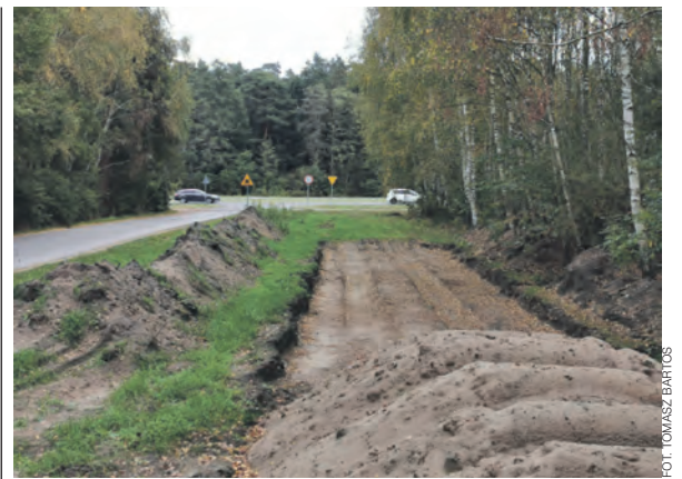
Wykorytany pas ziemi pod ścieżkę rowerową, która połączy Bobrowniki z drogą serwisową przy DK70.
