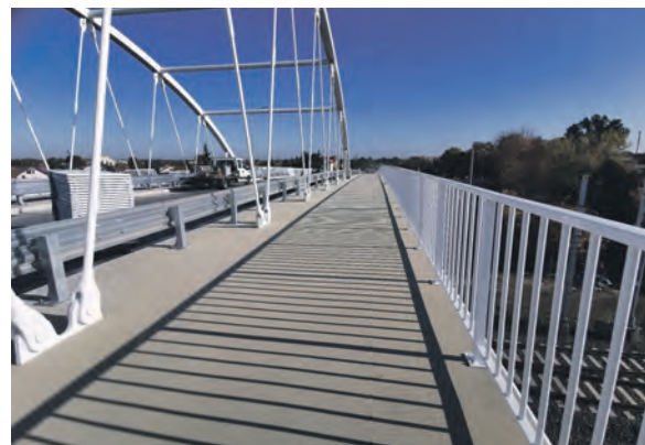
Firma Alu Force zainstalowała balustrady na łowickim wiadukcie, konstrukcja od razu zaczęła wyglądać na „pełniejszą”.
