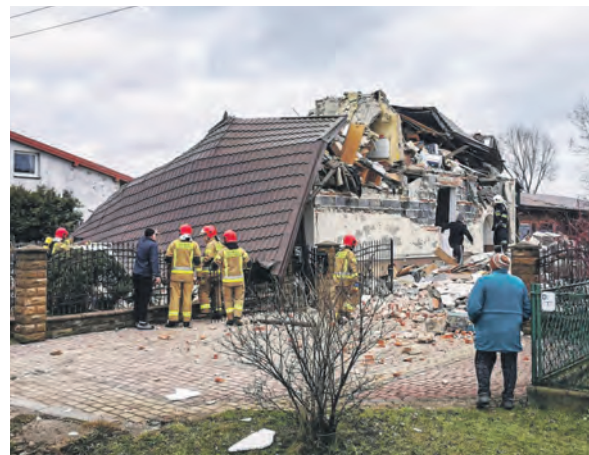
Pod wpływem wybuchu dom uległ częściowemu zawaleniu.
