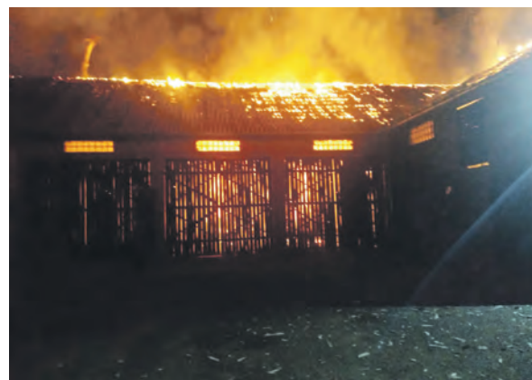
Pożar został zauważony przez sąsiadów w momencie, gdy strzelało już pokrycie z eternitu.
