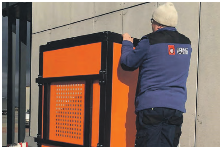
Montaż jednego z urządzeń do prania i suszenia na autostradowym MOP w pobliżu Strykowa.
