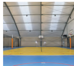
Wnętrze głównej części obiektu z boiskami wielofunkcyjnymi.
