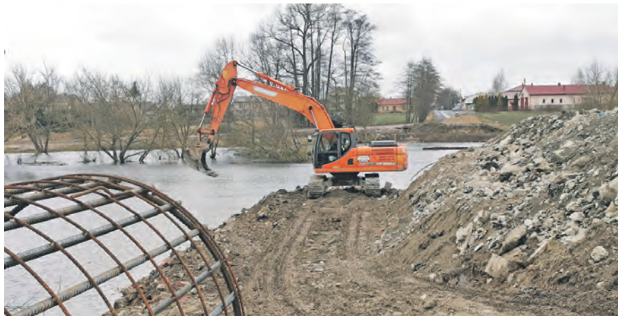
Firma, która wygrała przetarg na budowę mostu w Kompinie rozpoczęła już prace. Stan na 23.02.2022.
