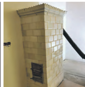
Zrekonstruowany piec kaflowy.
