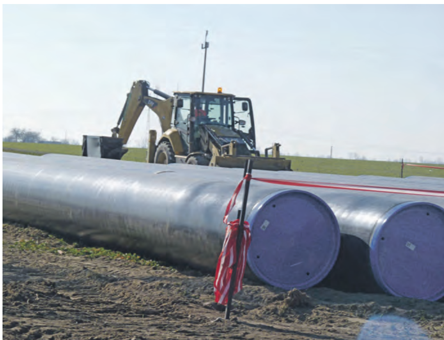
Pierwsze rury gazociągu o średnicy 100 cm już przyjechały do Świechowa, gmina Oporów, gdzie rozpocznie się ich układanie.
