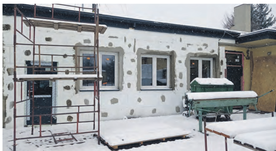
Prace remontowe budynku OSP w Głownie rozpoczęły się na początku marca. Czy wszystkie zaplanowane uda się zrealizować – zależy będzie od tego, czy jednostce uda się pozyskać brakujące pieniądze.
