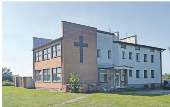
Budynek w Zdunach o powierzchni około 277 mkw. wymaga rozbudowy i kompleksowego remontu dla potrzeb „Domu na 105”.
