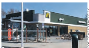
McDonald's w Sosnowcu, w trakcie prac wykończeniowych.
