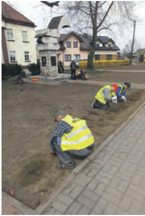
Prace prowadzi Jednostka Robót Publicznych w Strykowie.
