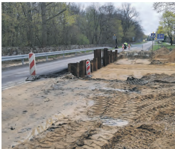
Teren przebudowy pierwszego mostu od strony Głównej.
