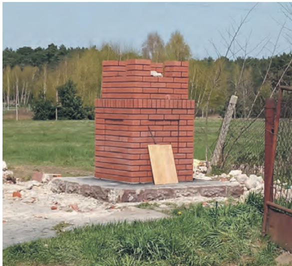
Budowa nowej kapliczki w Woli Lubiankowskiej, w ubiegły czwartek, 28 kwietnia.
