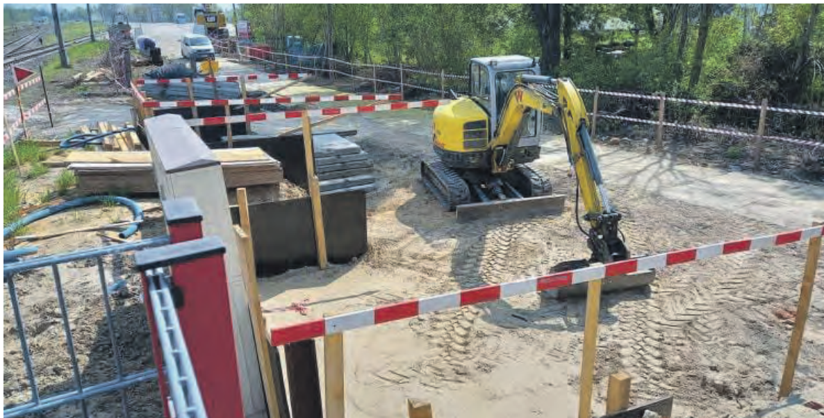
Wyrównywanie terenu pod prace w Strykowie.
