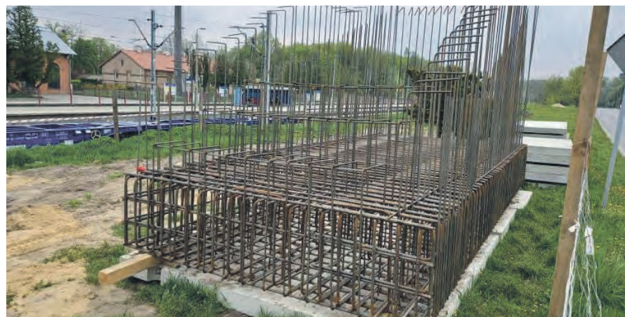
Zbrojenie pod podporę planowanego przejścia nad torami w Głownie.
