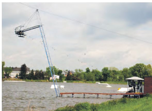
Widok na jeden z masztów wyciągu wake parku, przy brzegu widoczna wiatra z systemem jego sterowania.
