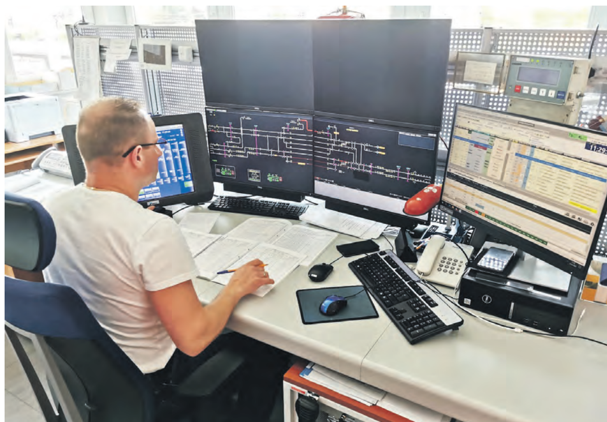
Stanowisko dyżurnego ruchu w nastawni, a w przyszłości Lokalnego Centrum Sterowania na dworcu PKP Łowicz Główny.
