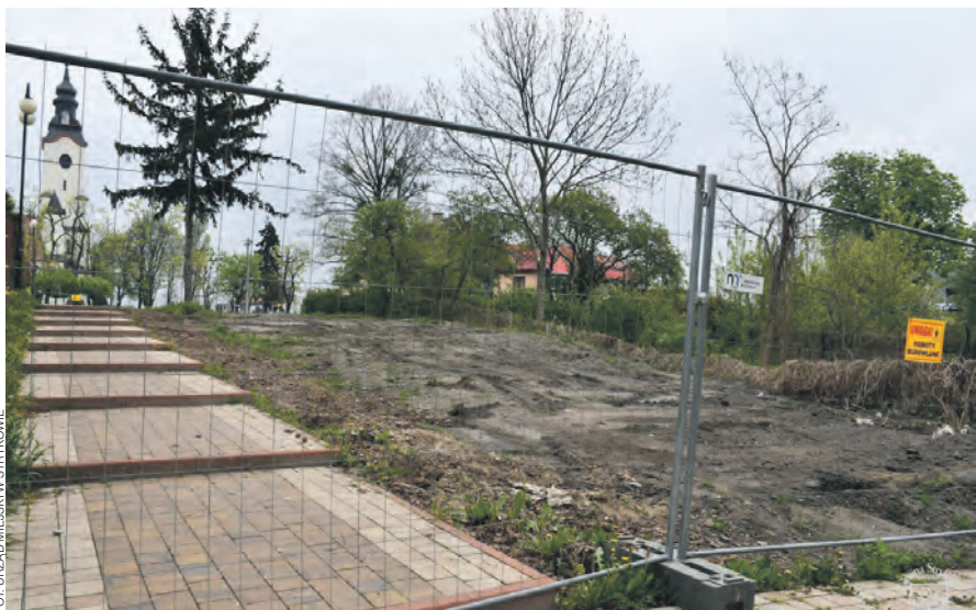
Miejsce prac od strony Moszczenicy.
