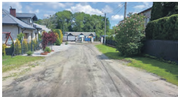
Ulica Zapolskiej – podobnie jak sąsiednie ulice, zyska asfalt z kanalizacją deszczową i zjazdami do posesji.
