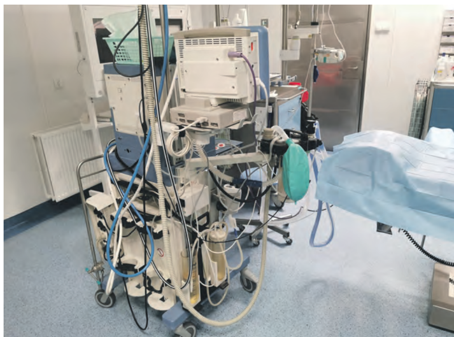
Wyposażenie sali operacyjnej: oprócz narzędzi znanych od lat – elektronika i automatyka.
