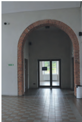
Poczekalnia przy dworcu kolejowym w Głownie świeci pustkami.
