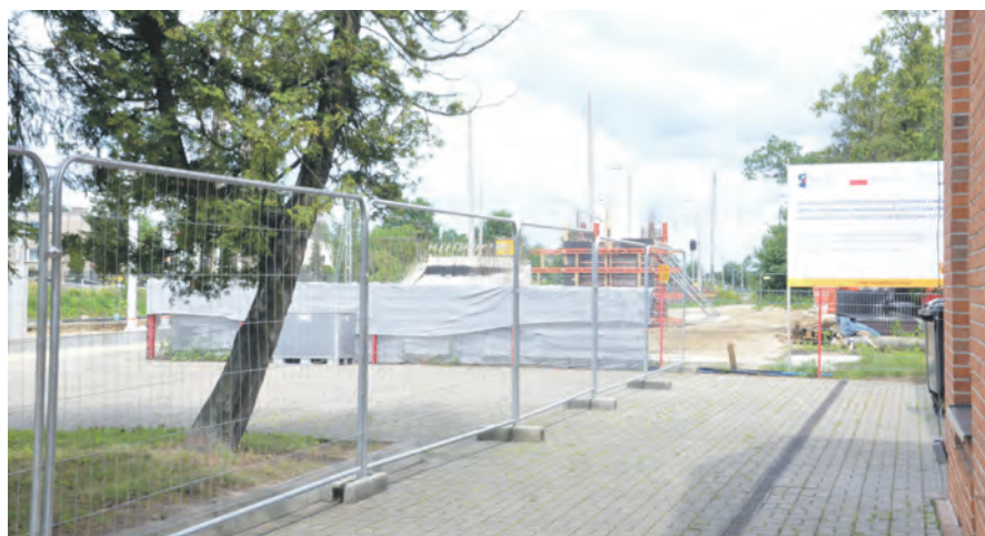
Przy peronach głowieńskiego dworca postawione zostały już kolumny przejścia nadziemnego.
