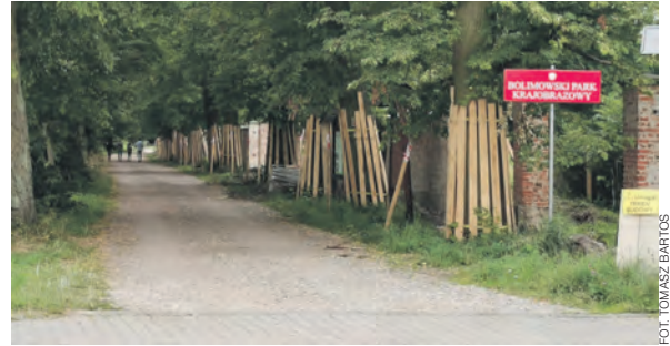
Aktualnie stare ogrodzenie jest zdemontowane od strony Alei Lipowej oraz od tzw. drogi Chylenieckiej, na zdjęciu pnie drzew zabezpieczone na czas robót.
