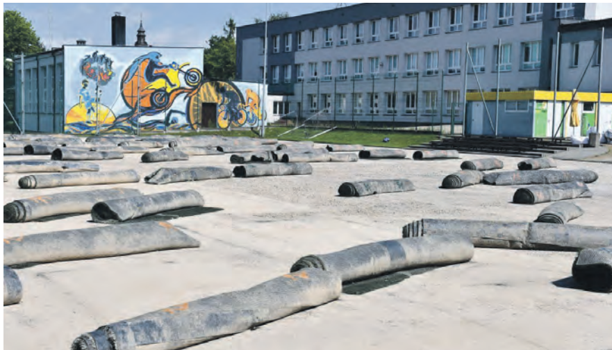
Jednym z elementów prac jest wymiana sztucznej nawierzchni boiska.
