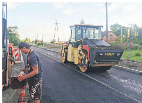
Prace przy naprawie nawierzchni DW 584 w Sannikach.
