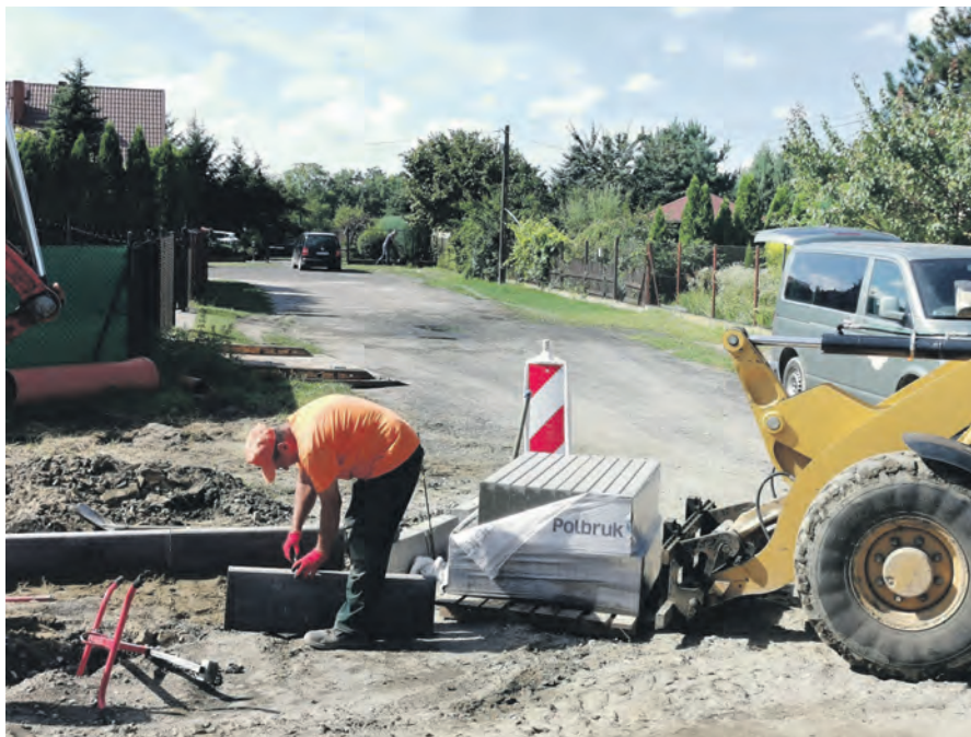
Prace na ul. 11 Listopada w Głownie prowadzone są pełną parą, ale miasto przy tej okazji nie wykona mieszkańcom dojazdu do posesji.
