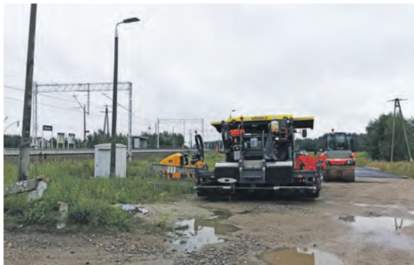
Ciężki sprzęt budowlany firmy Trakcja korzysta z drogi w Kęszycach i jest parkowany tuż przy niej, przy przystanku kolejowym.
