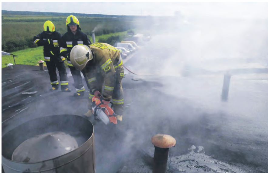
Strażacy wycinali otwory w poszyciu dachu piekarni, aby umożliwić oddymienie stropu i pomieszczeń produkcyjnych.
