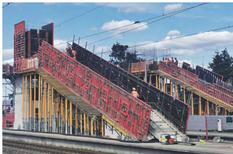
Prace przy budowie kładki nad torami w Głownie są najbardziej zaawansowane na peronie II (na pierwszym planie) i na peronie I (w głębi).
