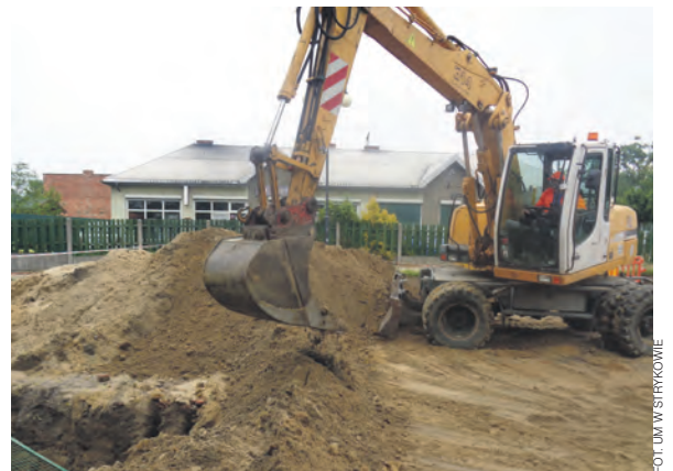
Firma wykonująca prace przy ul. Kościuszki w Strykowie opóźnia się z oddaniem inwestycji
