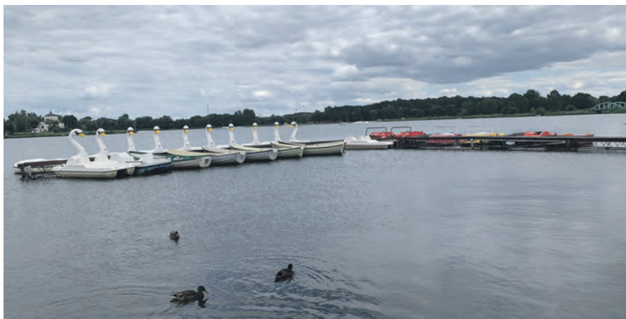
Ten pomost zostanie zastąpiony całkowicie nowym.
