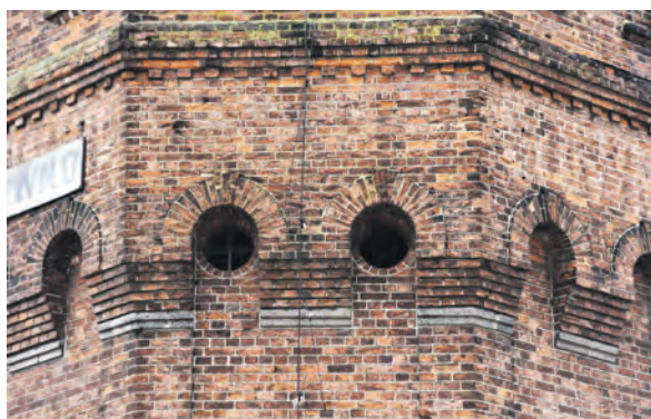
Na zdjęciach z bliska widoczne są detale architektoniczne oraz pierwotne rozwiązania materiałowe elewacji – nietynkowana cegła i dekoracyjna spoina.
