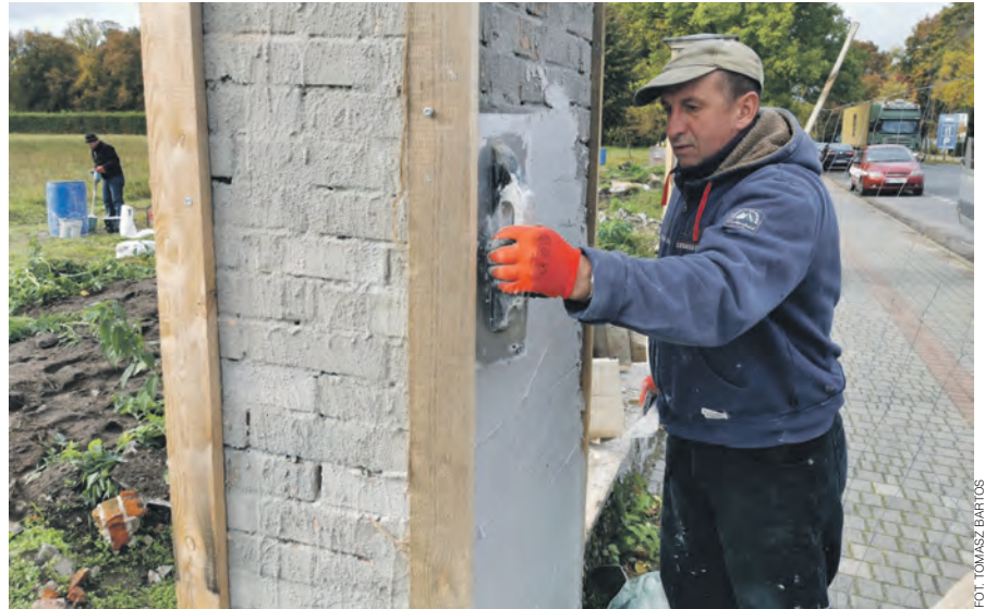
Trwają prace remontowe ogrodzenia wokół zespołu pałacowo-parkowego w Nieborowie.
