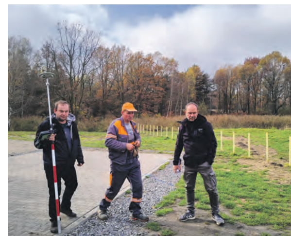
2 listopada rozpoczęły się prace przy budowie 220-metrowej ścieżki rowerowej przy parku linowym w Głównie. Wykonawca najpierw musiał poprosić geodetów o ponowne wytyczenie, ponieważ wcześniej ustawione tyczki ktoś zniszczył.
