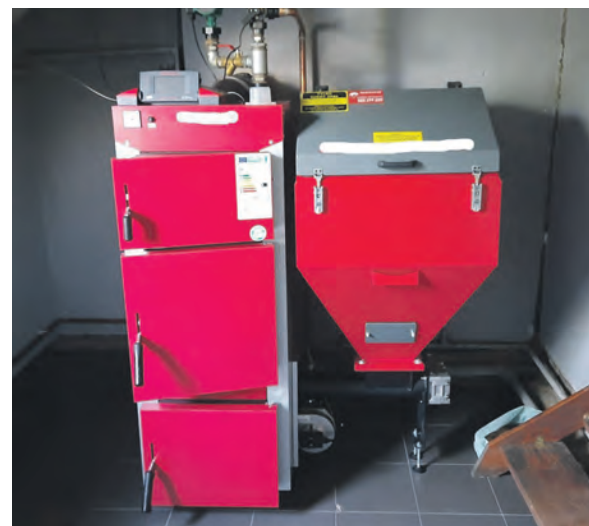
Nowe, niskoemisyjne źródła ogrzewania, zamontowano w sumie na 12 posesjach.
