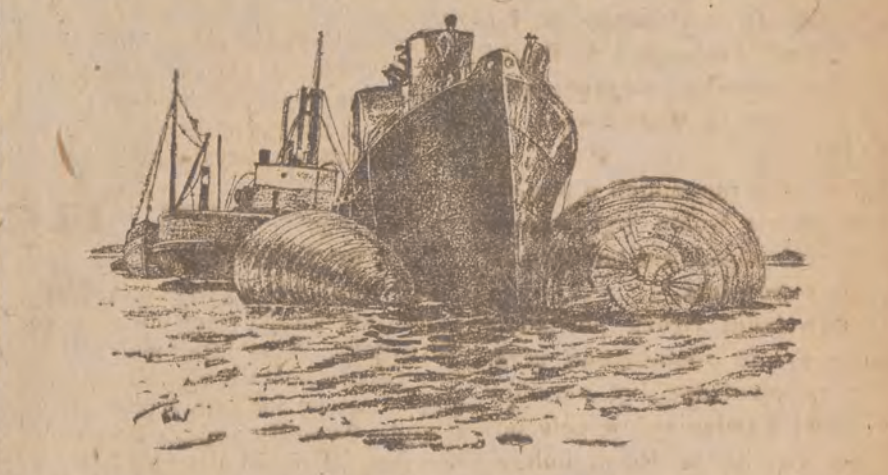
Okręt wojenny „S. 131” z balonami, z pomocą których wydobyto go na powierzchnię morza. Każdy z balonów posiada siłę nośną 150 tonn.
