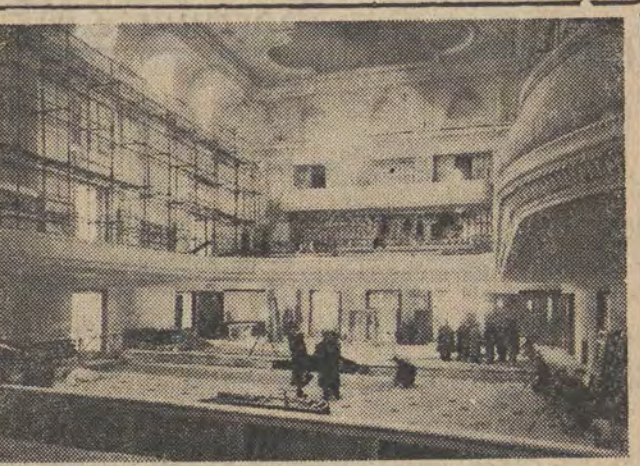
Trwają intensywne prace przy wykańczaniu wnętrza Filharmonii Warszawskiej. W holi i szatni kamieniarze układają posadzkę z płyt kamiennych i marmurowych a sztukarze kończą roboty przy rampach i sufitach. W sali koncertowej zmontowano już część boazerii, której ogólna powierzchnia wyniesie 380 m kwadratowych, ozdabia się sale tkaniną na wysokość balkonów i przygotowano kryształ do żyrandoli, których montaż rozpocznie się 12 stycznia br. Na zdjęciu: wnętrza sali koncertowej. CAF
