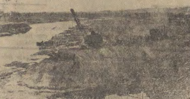
Próg na Odrze — fragment budowy.
