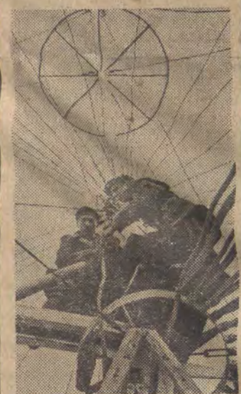
Na zdjęciu: robotnicy pracujący przy kopule pawilonu polskiego na terenie Targom.
