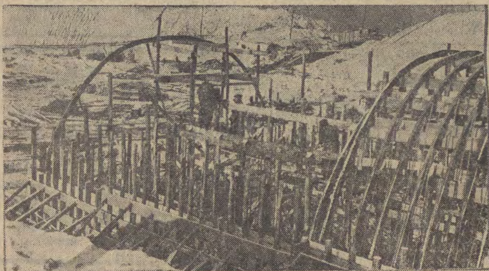
Z budowy stadionu festiwalowego w Warszawie.
