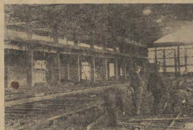
Znajdująca się w budowie nowa olbrzymia hala targowa o kubaturze 50 tys. m sześć. ukończona zostanie z końcem kwietnia.
