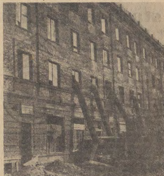
Blok nr 110 przy ul. Franciszkańskiej „wyciągnięto” już pod dach. Dokonuje się ostatnich zabiegów — maluje wnętrza, suszy mieszkania. Już wkrótce wprowadzą się tu pierwsi lokatorzy...
