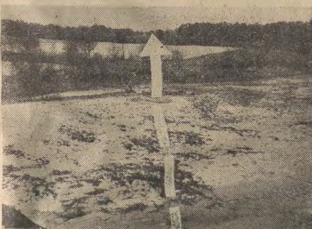
Na razie jest to płaszczyste nadbrzeże. Już za parę miesięcy jednak przebiegać tędy będzie nowe koryto Widawki. Uregulowana rzeka wpłynęła zostanie w służbę człowieka...
