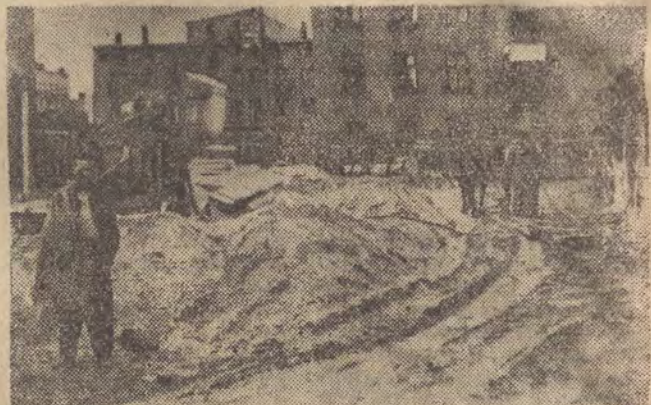
Oto budowa bloku 105 na Starym Mieście (ZBM — odcinek budowlany nr 2). I tu nie pomyślano o jakimkolwiek zabezpieczeniu żwiru przed marnotrawstwem. Fot. L. Olejniczak
