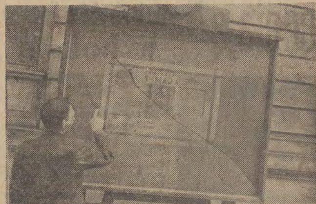
Pasaż ZMP — wszystkie gabloty utrzymane niechlujnie, fotografie powyrwane, brudne, stare, nieaktualne. fot. L. Olejniczak
