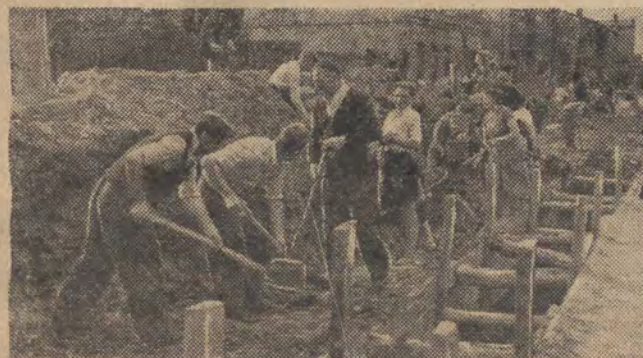
Tu pracują mieszkańcy ul. Wapiennej przy zasypywaniu rowów kanalizacyjnych.
