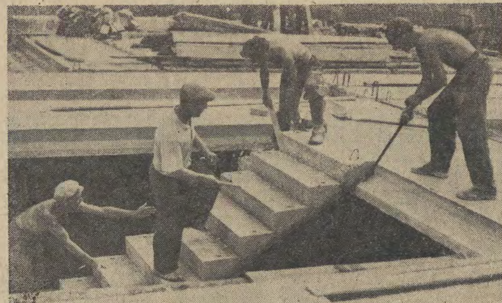
Oto ostatnie prace przy montażu schodów. Za chwilę będziemy mogli po nich zejść na dół. Na zdjęciu: majster Trzciniński pomaga brygadzie betoniarstwa Kłosa przy ułożeniu schodów. Fot. L. Olejniczak
