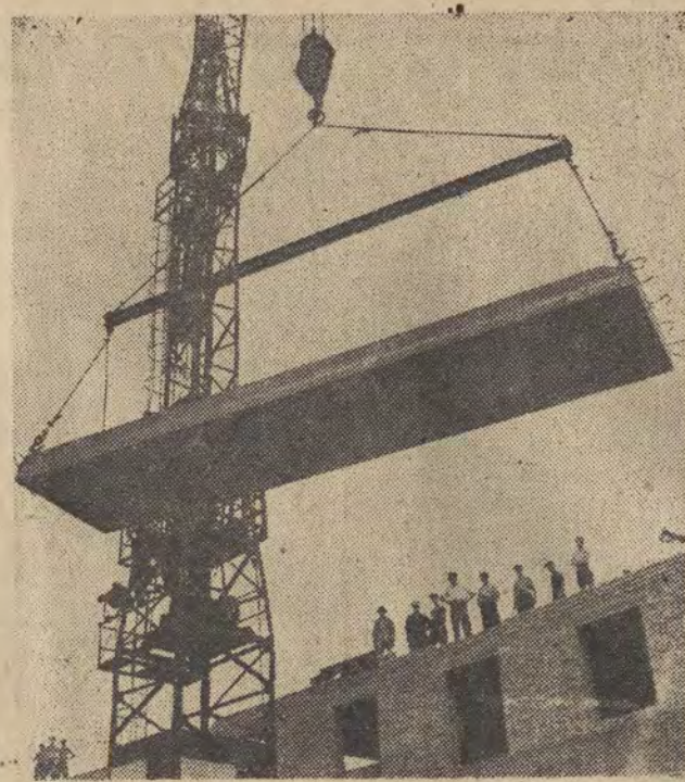
Nasz fotoreporter uchwycił moment windowania przez żuraw 2 i pół-tonowego stropu. Za chwilę będzie on montowany na budowie bloku 442.
