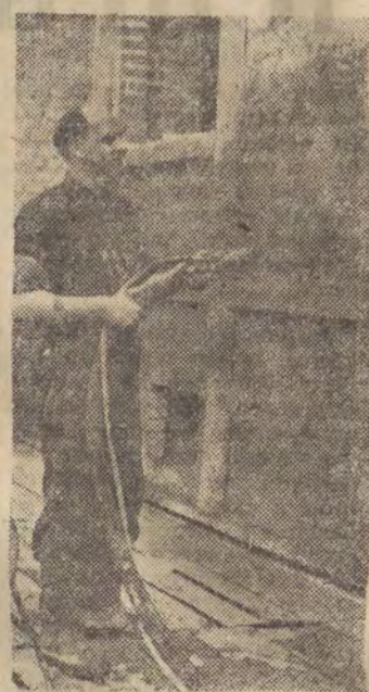
Inż. arch. Tadeusz Popielecki przeprowadza próbę mechanicznego tynkowania.
